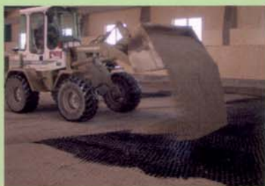
5 Verfüllen mit Radlader
