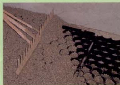
6 Restliches Verteilen von Hand
