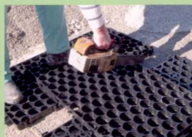
4 Schneiden der Platte mit einer Säge
